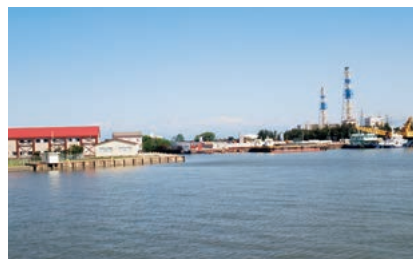
旧実習場と建設中のLNG船専用岸壁
