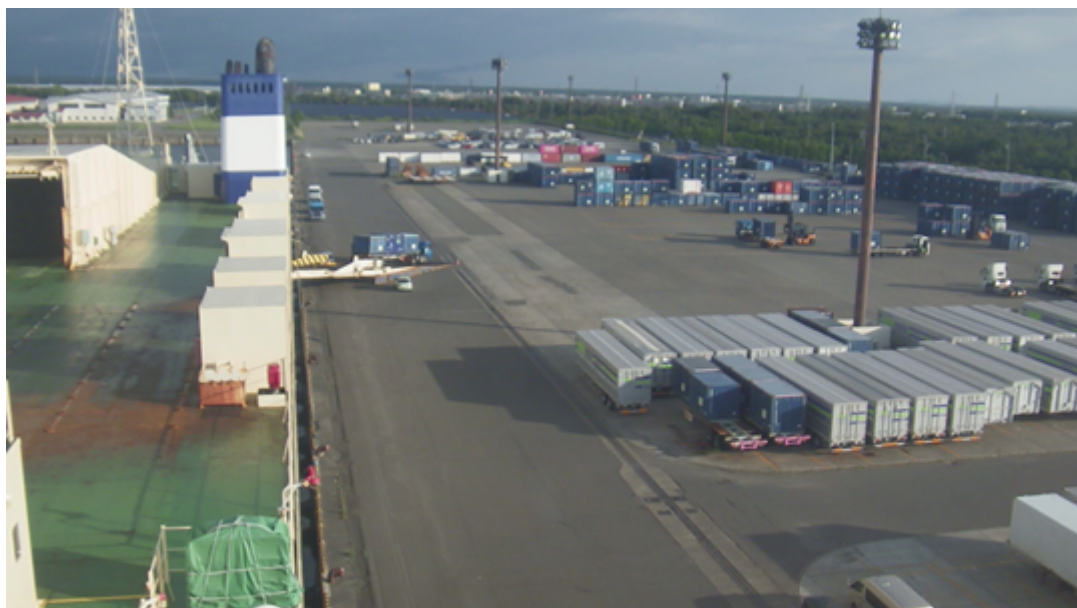
図 4 苫小牧での荷役状況（荷役作業の撮影動画から切り出し）
