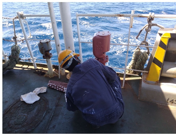
図2 ペイント塗装作業
