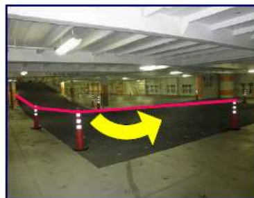
図 16 安全コーンとビニールテープによる走行路
