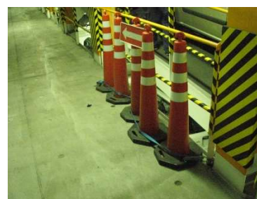
図 17 安全コーンおよびトラマークのプロテクター
