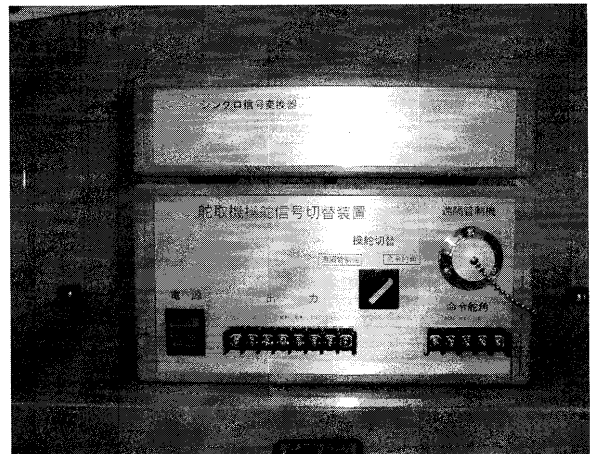
写真1 シンクロ信号変換器の増設
