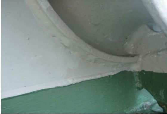
図9 新しい防錆方法により整備した箇所(4年経過)
