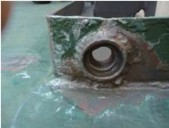
図5 電動工具により錆の除去を行った状態
