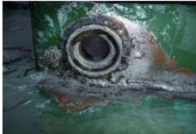
図7 溶剤を繰り返塗布を行った状態
