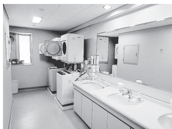
【1号館洗濯洗面室】
